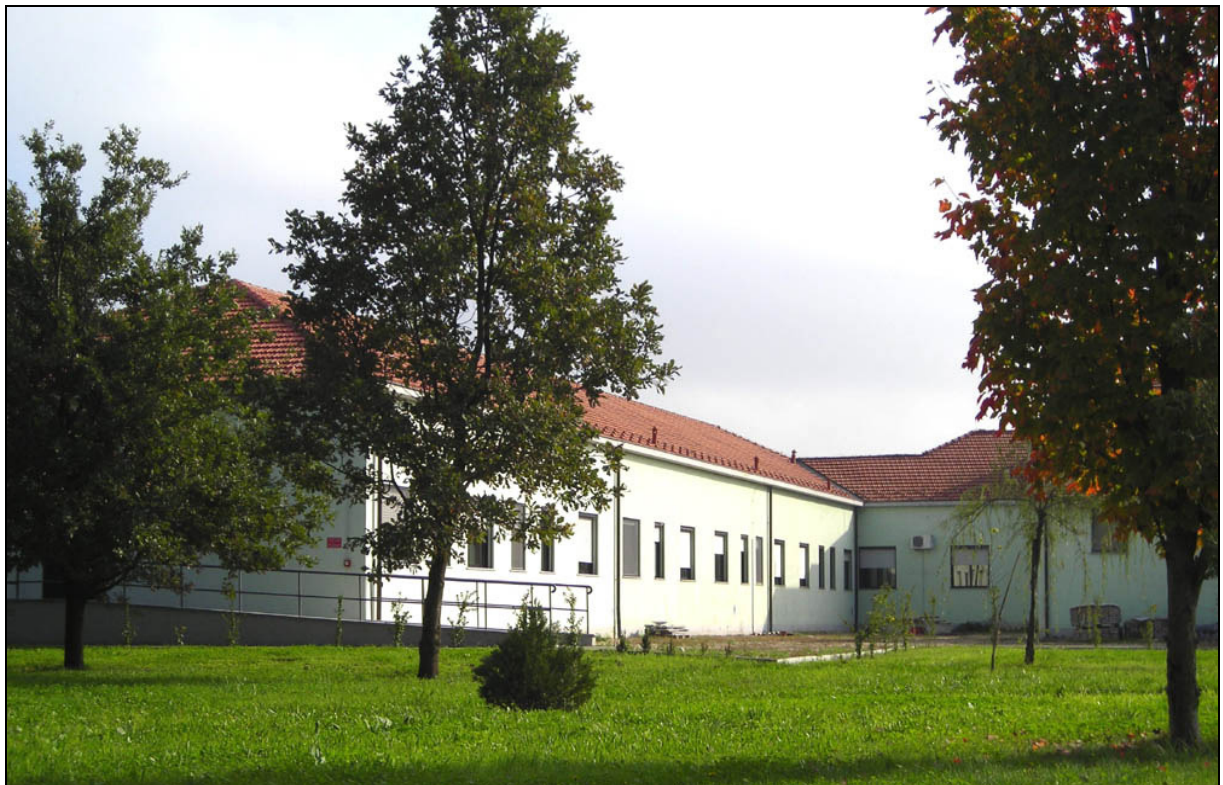
Parco sul retro della struttura
